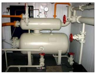
По мере накопления нефти поплавок регулятора уровня поднимается и, будучи жестко связанным с газовой заслонкой, перекрывает газовую линию. Давление в сепараторе начинает расти.
