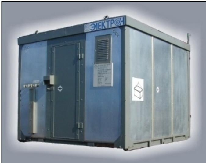
Пункт контроля и управления предназначен для размещения аппаратуры контроля и управления технологическими объектами добычи нефти и закачки воды.
