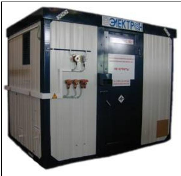
Установка предназначена для дозированного ввода жидких химреагентов (деэмульгаторы, ингибиторы коррозии, ингибиторы солеотложений, ингибиторы парафиноотложений, бактерициды и т.д.) в трубопроводы промышленных систем сбора, транспорта и подготовки нефти, систем поддержания пластового давления, в нагнетательные и эксплуатационные скважины с целью защиты трубопроводов, колонн скважин и нефтепромыслового оборудования от коррозии, отложения солей, парафина и т.д.
