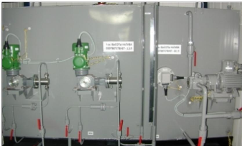
Все оборудование установки размещено в утепленном блоке с герметичным утепленным рамным основанием. В качестве ограждающих конструкций блока использованы стальные трехслойные панели с утеплителем из пенополиуретана с пламегасящими добавками.
